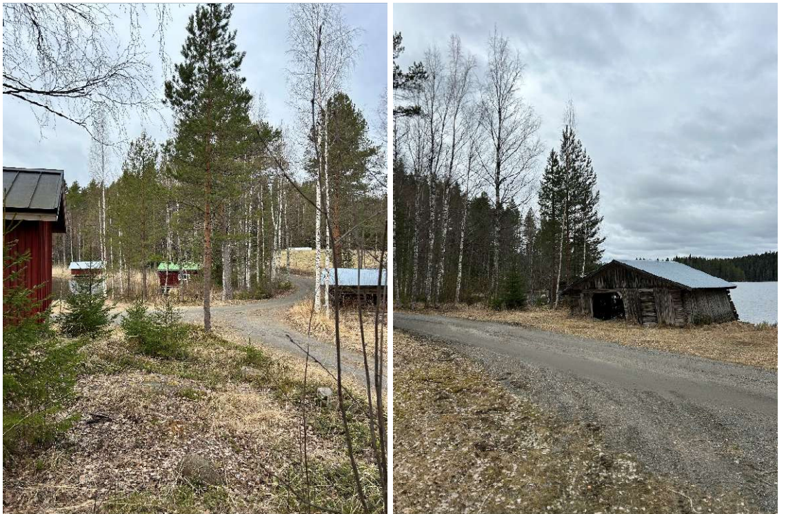
KUVAT 10 ja 11 (30.4.2026): Riuttaniemen rannassa mökki, lato sekä 3 venevajaa.
