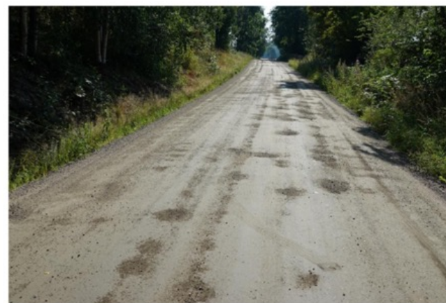
Kuva 4. Tien pinnalla on kuoppia, joita ei pysty väistämään omalla ajokaistalla. Kuntoarvo 2, alaraja.
